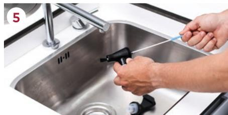
**5** Démontez la partie supérieure du robinet et nettoyez l'intérieur avec le goupillon fourni à cet effet.
